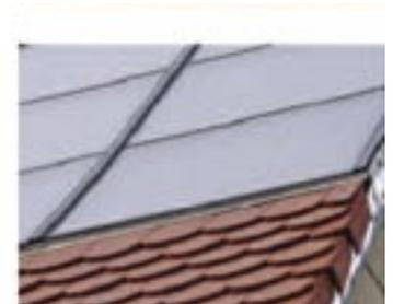
6. Keine „Sägezahn-Lösungen“! Die Solaranlage sollte an die vorhandenen Gegebenheiten angepasst werden.
