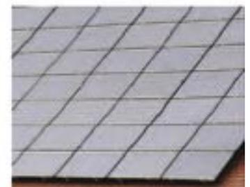
5. Wenn Module in die Dachfläche integriert werden und bündig mit der Dachkante abschließen, entsteht ein ruhiger Gesamteindruck.
