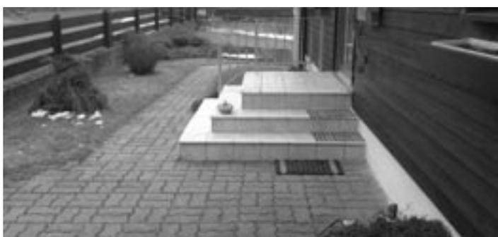
*Diese Hauszugänge wirken trostlos. Die Zugänge wurden mit ortsuntypischem Material –Verbundpflaster und Waschbetonplatten– belegt. Der Fliesenbelag der Stufen platzt ab und es besteht die Gefahr des Ausrutschens.*
